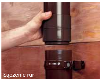
Montaż rur do ściany murowej
